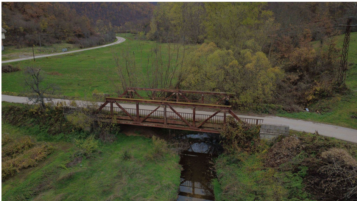
Гвоздени мост на Туларској реци, фотографија: Н. Петровић, 2025.
