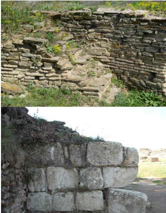
Ivana Cvetković: a/ Inappropriate Choice of Stone Type/Pogrešan izbor kamena; b/ Weak Mortars-Slab Malter; c/ Biological Colonisation-Biološka kolonizacija
